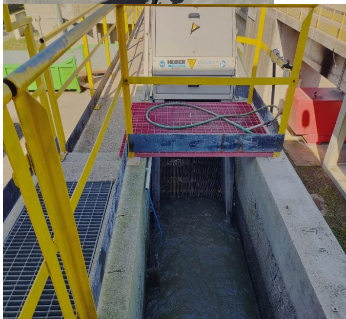
Misuratore di portata in ingresso e canale di ingresso con grigliatura
