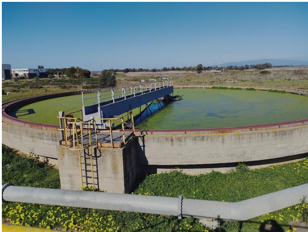
Sedimentatore secondario B
