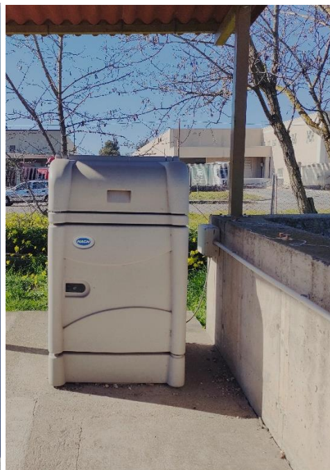
Scarico finale ed autocampionatore
