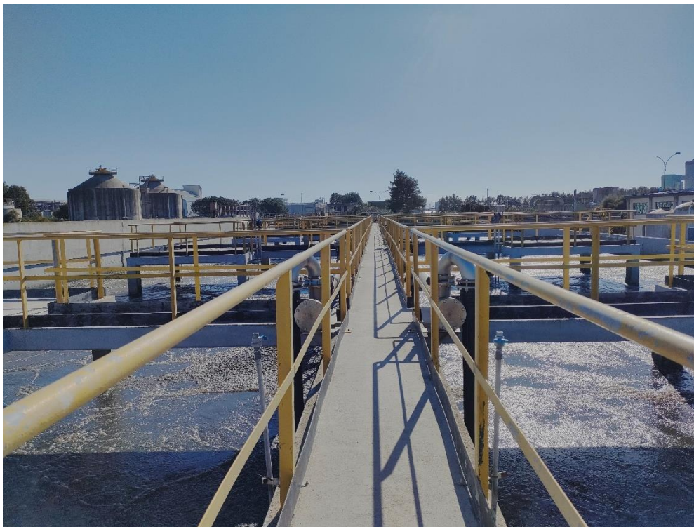
Vasche di nitrificazione-ossidazione
